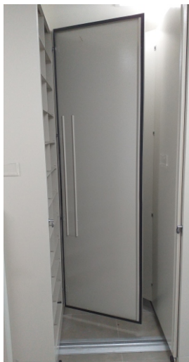
Porta com reforço e vedação com borracha especial da 3M
